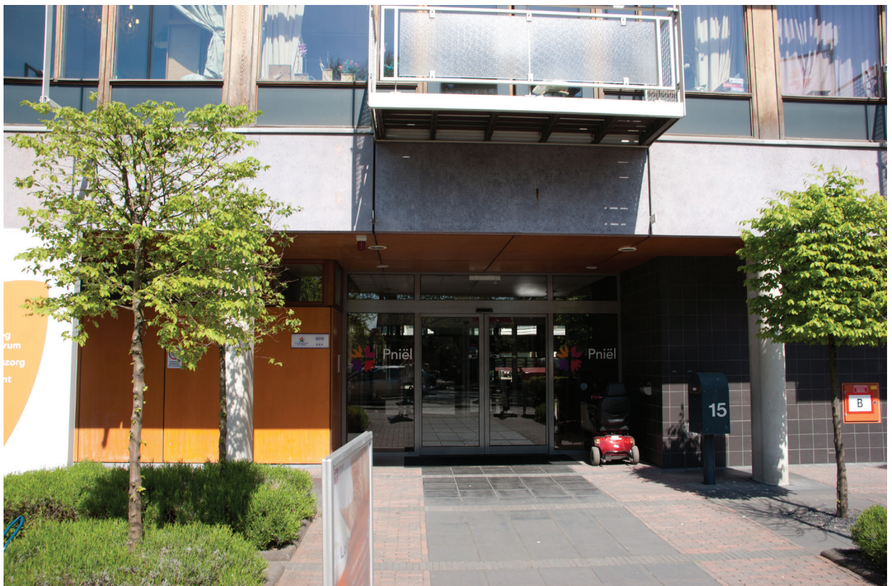
Afb. 2.1: Ingang Pniël aan de Oudedijk | Veldacademie
